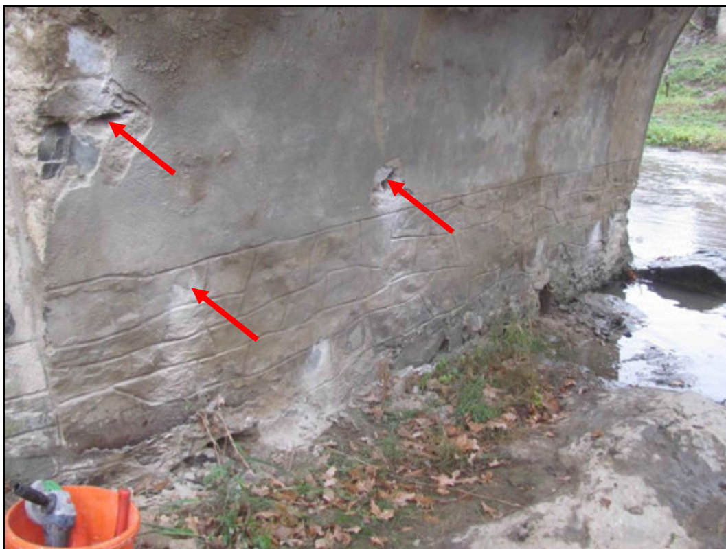
Foto 4: Detail provádění sond pro určení pevnosti kamenného zdiva a hloubky degradace materiálu.
