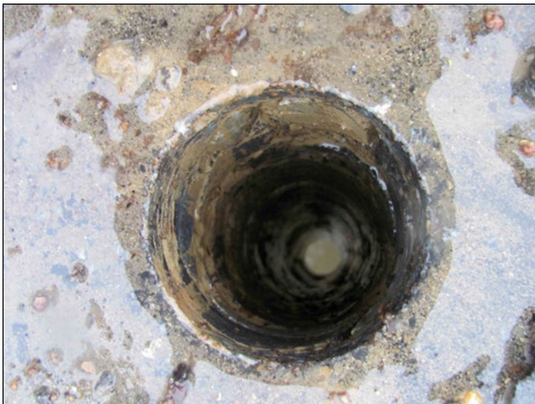
Foto 3: Pohled do jádrového vrtu pro určení skladby mostovky a tl. klenbového pásu.
