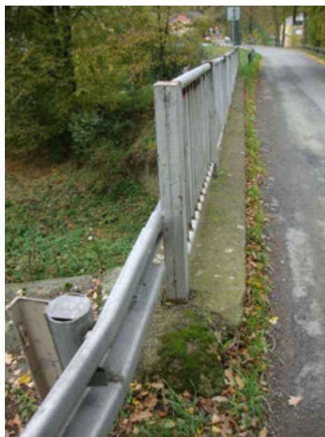
Obr. 8: Pohled na levou římsu – ukončení svodidla u O1.
