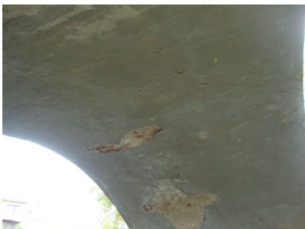
Obr. 19: Podhled NK – průsaky, odpadávající omítka.
