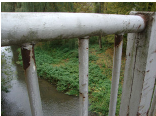
Obr. 27: Detail koroze zábradlí.
