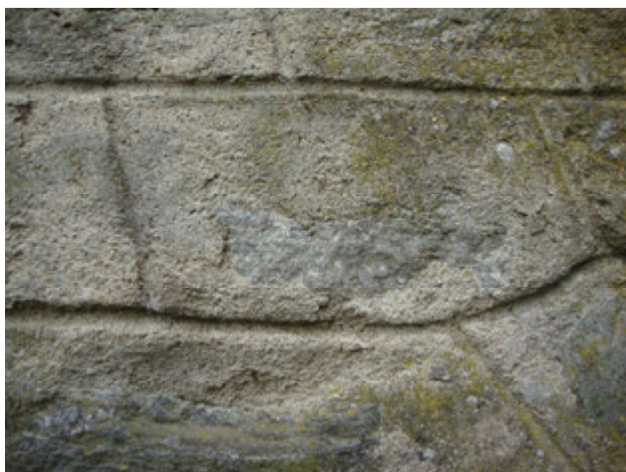
Obr. 13: Detail odpadávající omítky na kamenném zdivu.
