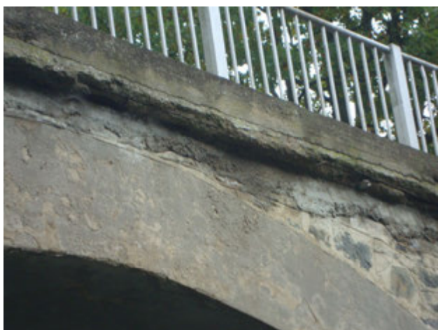
Obr. 35: Podhled na degradovanou levou římsu.
