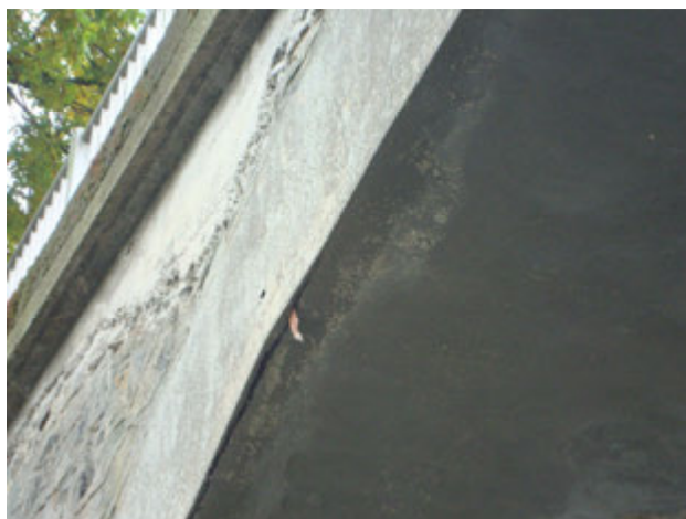
Obr. 18: Odpadávající vrstva na povodní straně mostu.
